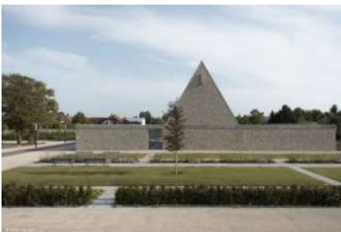
Aussegnungshalle Ingelheim in Frei-Weinheim
